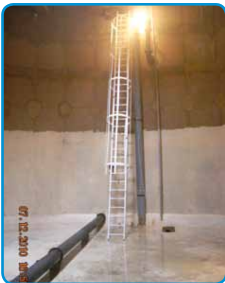
Revêtement béton et enduit
