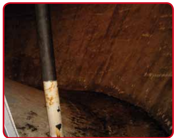
Revêtement époxy, photo B
