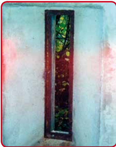
Aération non grillagée
