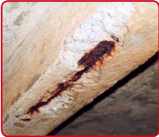
Poutrelle érodée, armature à nu
