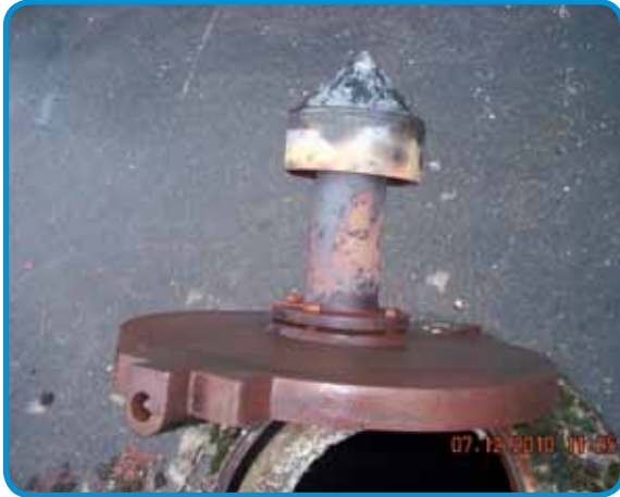
Capot-regard avec cheminée d'aération Fonctionnel et sécurisé
