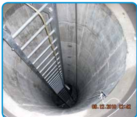
Sécurisation d'un ouvrage de grande hauteur
