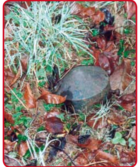
Cheminée d'aération enterrée
