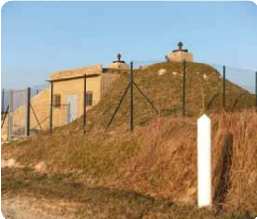
Réservoir semi-enterré
