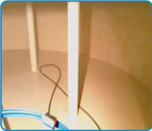
Revêtement après plusieurs nettoyages
