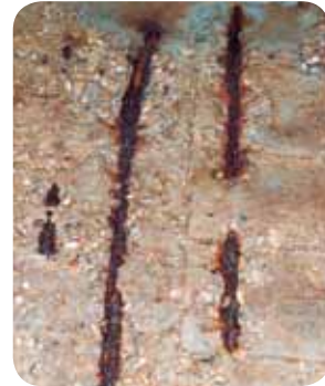
Poutrelle érodée, armature à nu
