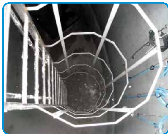
Taille et implantation optimales de l'échelle et de la crinoline
