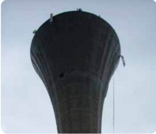
Réservoir sur tour
